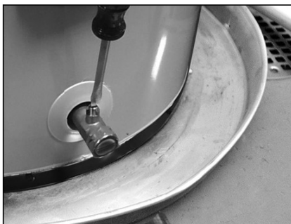
Figure 31 - Vidanger le chauffe-eau.
