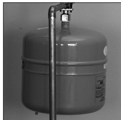
Figure 20 - Le vase d'expansion doit être pressurisé à l'air à une pression égale à celle de l'arrivée d'eau du domicile.
