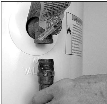
Figure 13 - Dépose du tuyau d'écoulement de la soupape DST
