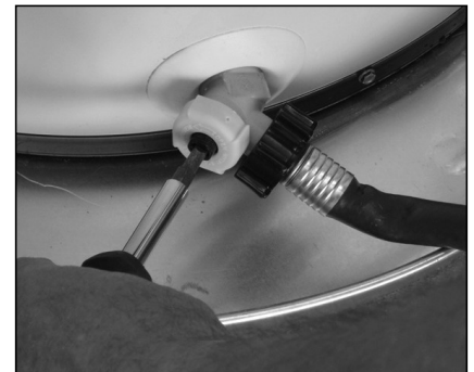
Figure 12 - Vidanger l'ancien chauffe-eau.
