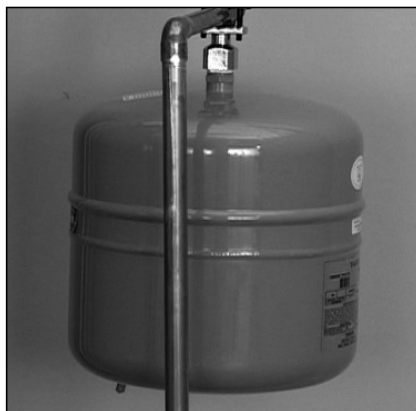
Figure 6 - Le vase d'expansion protège la plomberie du domicile contre les pointes de pression.
