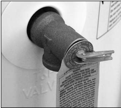
Figure 16 - Soupape de décharge à sécurité thermique
