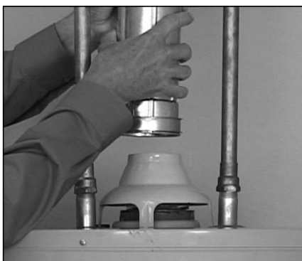
Figure 14 - Détacher le conduit d'évacuation du coupe-tirage.
